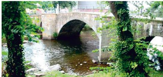
Die Brücke wurde aus **Grauwacke-Bruchstein ohne Mörtel** errichtet. Die drei Bögen sorgen für die nötige statische Festigkeit. Durch den nahezu verdoppelten Radius des Hauptbogens gegenüber den äußeren Bögen ergab sich ein **charakteristischer „Buckel“**. Die Vorbauten der
